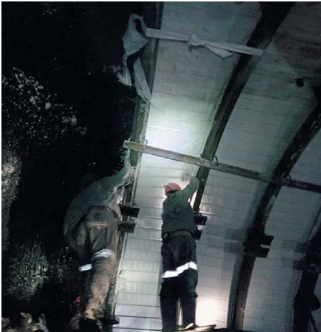
Рис. 5 Проходчики во время крепления
