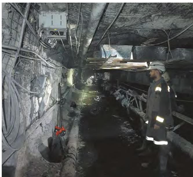
Рис. 2 Окончание водяного заслона, место крепления БС в центре контролируемого участка
