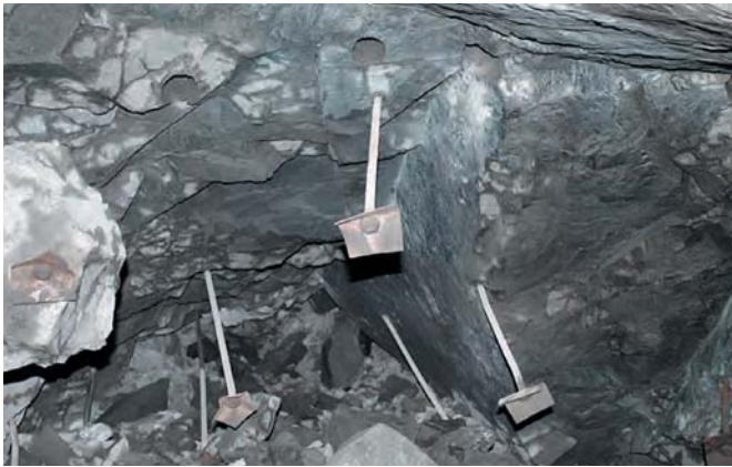
Рис. 3 Характер нарушений в кровле выработки при одновременном взрывании скважин в веере
