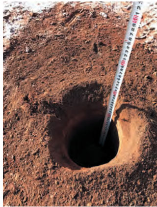
Рис. 3 Замер глубины скважины
