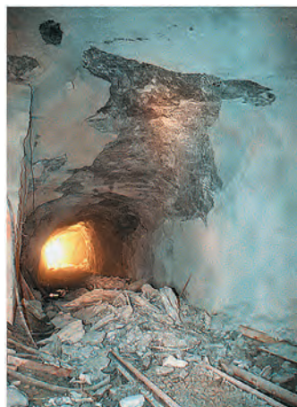
Рис. 8 Изменение сечений выработок в результате динамических проявлений горного давления
