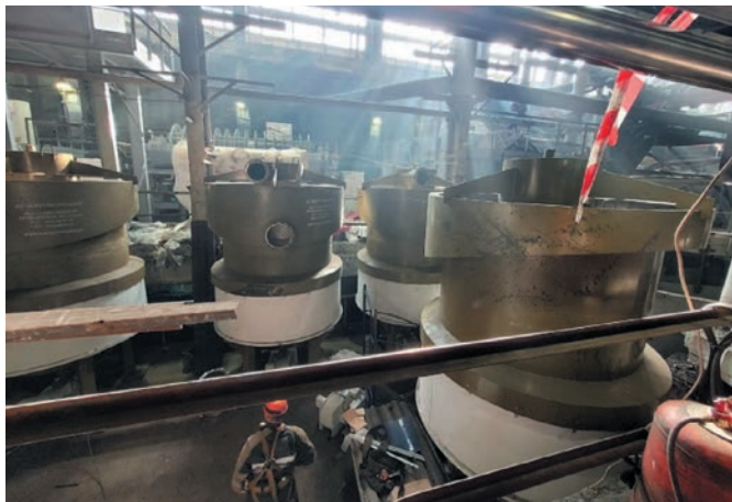
Рис. 1 Монтаж магнитно-гравитационных сепараторов МГС-2.0 на участке обогащения ЦРПО АО «ССГПО» (Казахстан)
