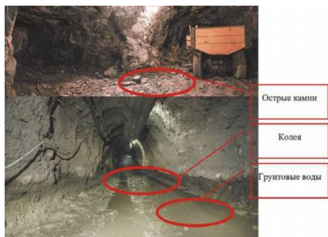
Рис. 1 Дороги в подземных рудниках
