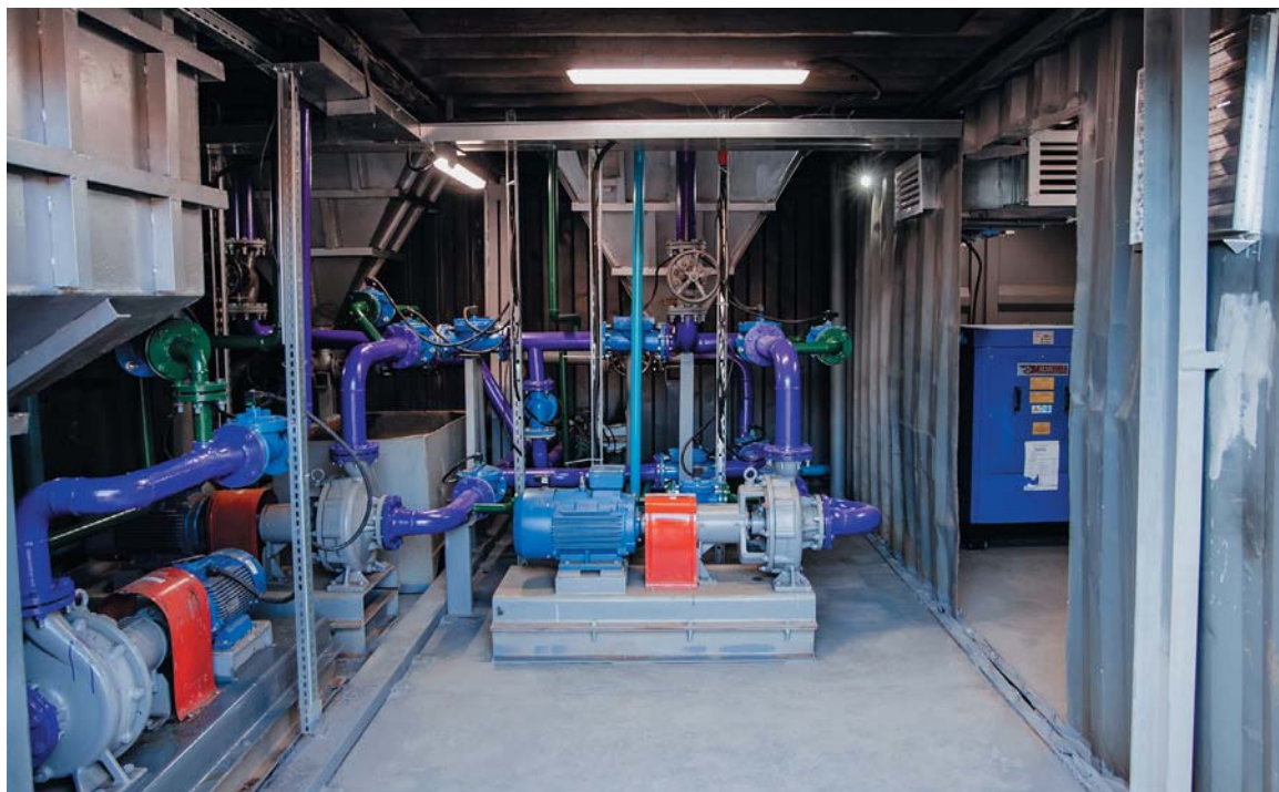
Рис. 3 Вид машинного зала. Все задвижки включены в общую схему АСУ и управляются автоматически
