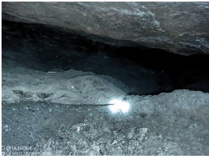
Рис. 2 Фото образовавшейся полости в пласте монтажной камеры 4-1-5-8(2) после выброса метана и угля 01.04.2022 г.
