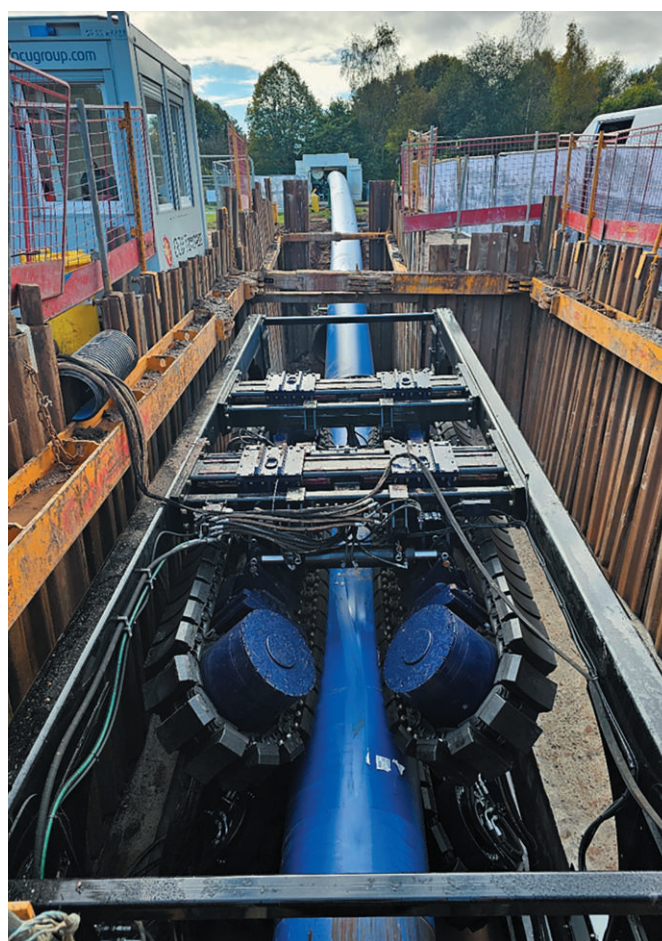
Рис. 3 Установка для домкратного продавливания труб (г. Манчестер, Великобритания)
